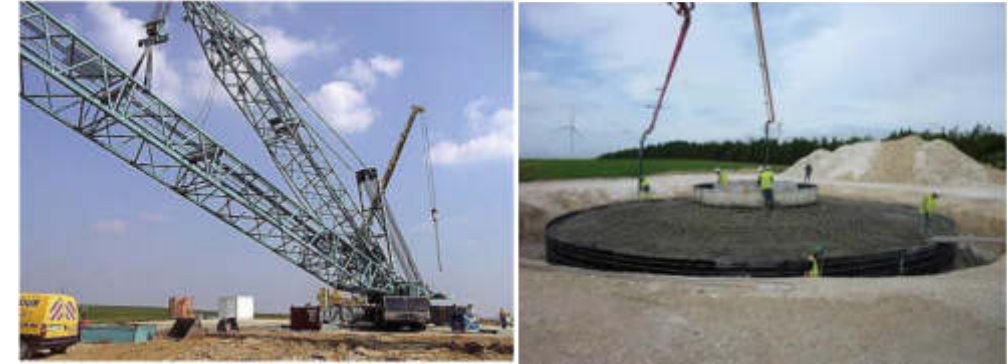
Figure 13 : De gauche à droite : grue de levage sur une plateforme et mise en œuvre d'une fondation
